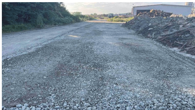
Slika 8. Izvedeni nevezani zastor interne ceste od drobljenog kamena [32]
