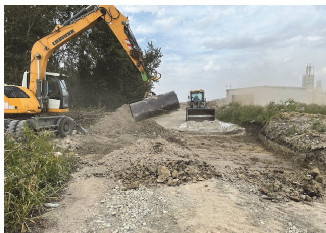
Slika 10. Miješanje drvnog pepela i usitnenog materijala iz iskopa [32]
