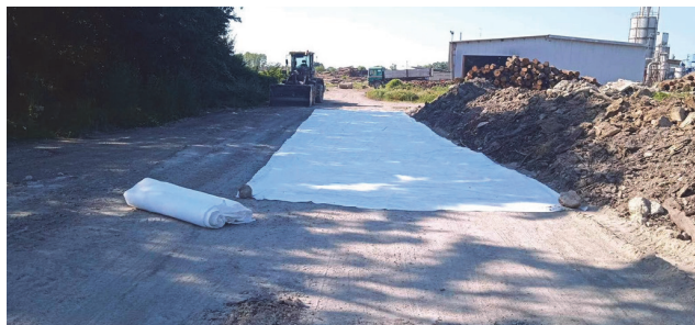
Slika 7. Geotekstil na nosivome sloju drvnog pepela [32]
