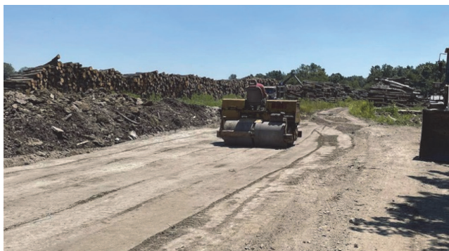
Slika 6. Zbijanje nosivog sloja od drvnog pepela
