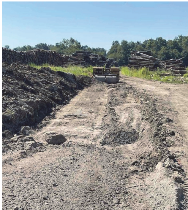
Slika 5. Nasipavanje nosivog sloja od drvnog pepela
