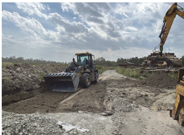
Slika 11. Razastiranje mješavine drvnog pepela i materijala iz iskopa
