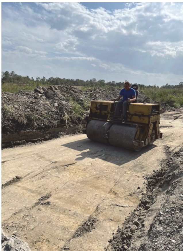
Slika 12. Zbijanje posteljice stabilizirane drvnim pepelom
